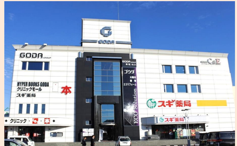
ゴウダ(株)本社 (ゴウダ C & Eビル)
